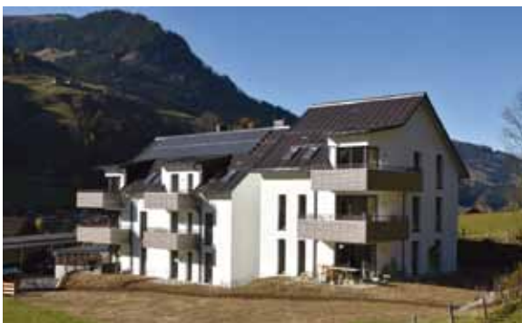
Wohnprojekt „Feldweg, Kleinarl“, © Salzburg Wohnbau GmbH
